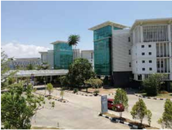
図2 円借款により建設された校舎群（撮影筆者）
