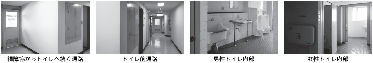
写真4 福祉センターのトイレ周辺環境およびトイレ内部
